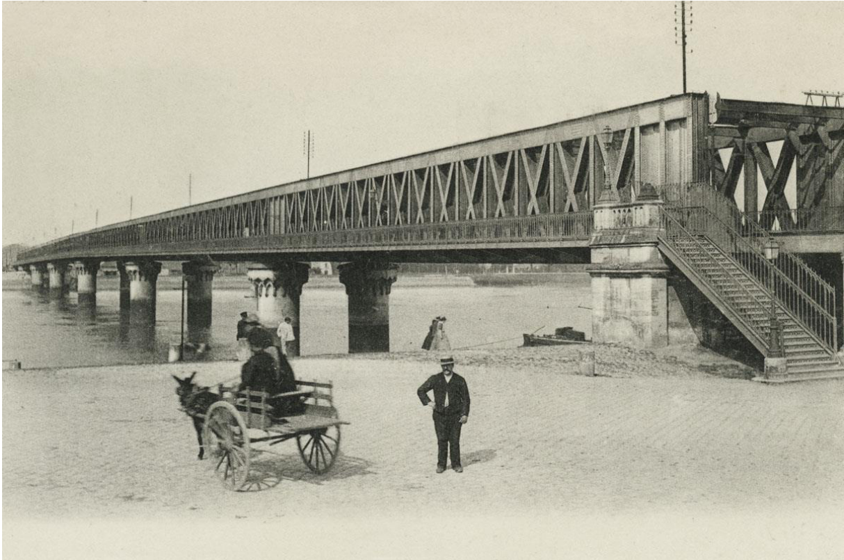
La Passerelle ST Jean à Bordeaux
