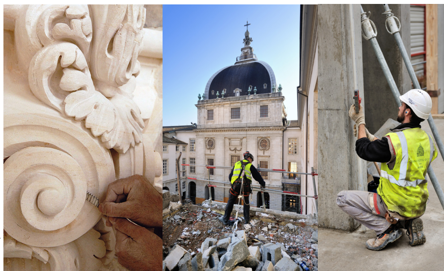
> Eiffage mobilise ses savoir-faire sur ce chantier hors normes
